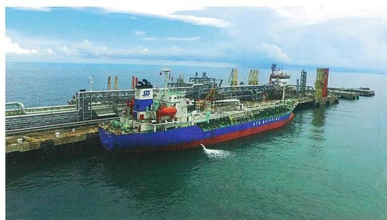
ก่าเรือปีโตรเคมีและปีโตรเลียมเหลว หรือ ก่าเรือ LCT ให้บริการ ก่าเทียบเรือเพื่อขนถ่ายสินค้าประเภทของเหลวและก๊าซ ด้วยอุปกรณ์ ขนถ่ายสินค้าที่กันสมัย มีประสิทธิภาพและปลอดภัย โดยมีความยาว กว่า 1,623 เมตร ประกอบด้วย ก่าเทียบเรือขนาดใหญ่ 6 ท่า สามารถ รับเรือได้ตั้งแต่ขนาด 1,000 - 250,000 ตัน มีปริมาณสินค้าผ่าน ก่า 15 ล้านตันต่อปี และรองรับเรือมากกว่า 2,000 ลำต่อปี
